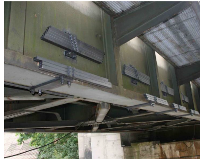
Figures 3 : Absorbeur sur rail & absorbeur sur platelage
