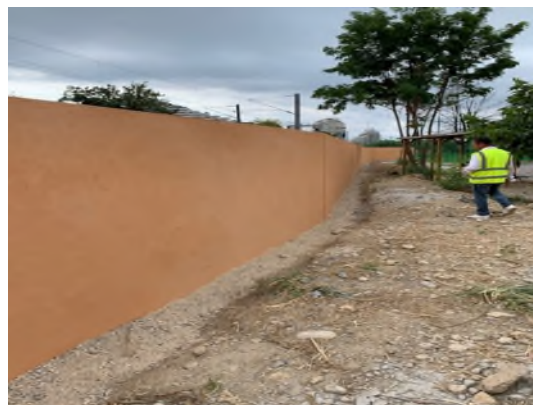
Figure 11 : Photo du mur acoustique au niveau de l'école Anthony Fabre
