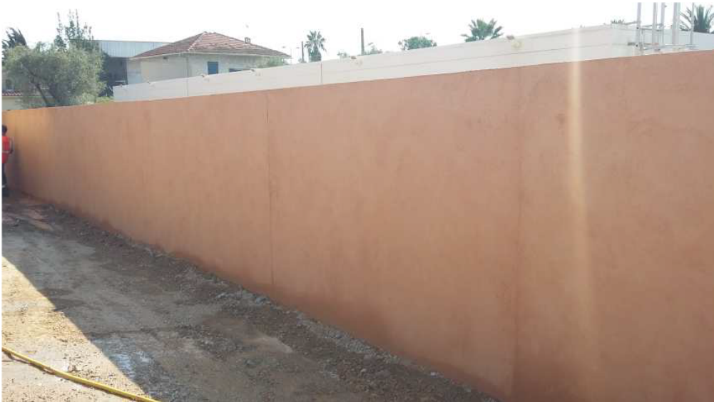
Figure 9 : Photo du mur réalisé
