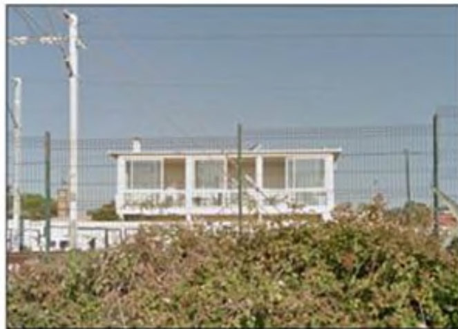
Figure 10 : Photo de la protection de façade réalisée
