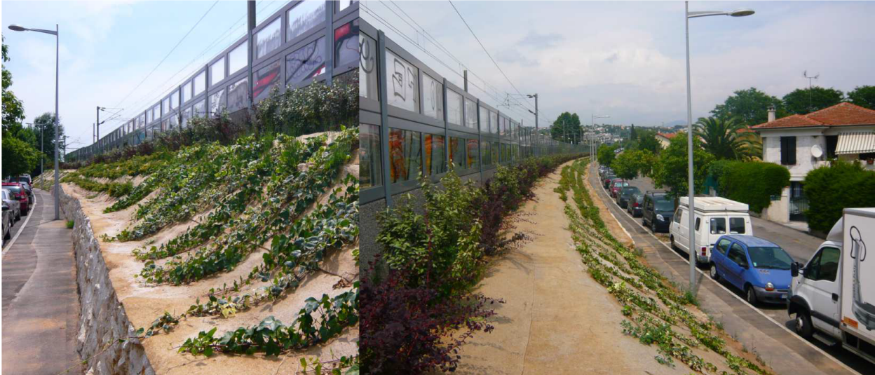
Figure 7 : Photos de l'écran acoustique réalisé à Cagnes-sur-Mer
